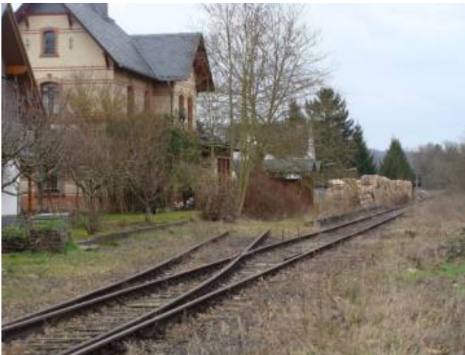
Das alte in Privatbesitz befindliche Bahnhofsgebäude in Allendorf (Lumda) und die davor liegende Gleisanlage. Der Abschnitt Staufenberg-Mainzlar bis Rabenau-Londorf ist komplett stillgelegt. (Foto: Thomas Kraft).
