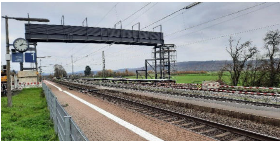
Bahnstation Niederwalgern: Die Stahlbrücke und der provisorische Bahnsteig an Gleis 3 sind im Bau für die Fahrtrichtung Marburg. Auch hier ist der alte Mittelbahnsteig für das Gleis 2 zu erkennen. (Bild: Thomas Kraft)
