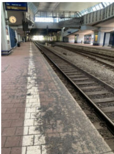
Splitt am Gleis 9
