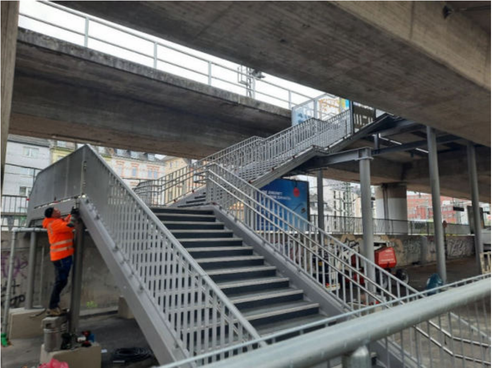
Ein Blick von der Straßenebene der Hamburger Allee über den Bauzaun auf die Treppe. Darüber die S-Bahn-Gleise 1+2 der Hochbahn, dahinter der Bahnsteig, Gleis 3. (Foto: Thomas Kraft)
